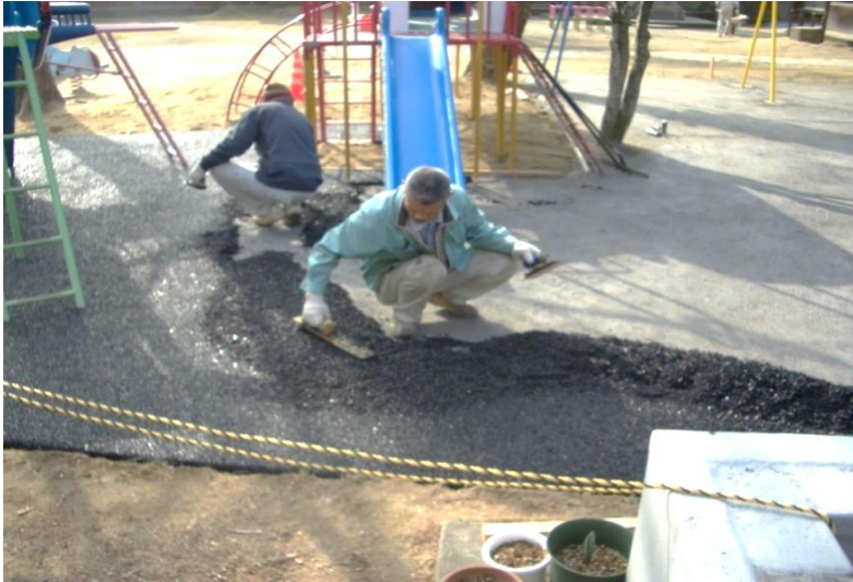
砕石路盤転圧後リサイクルゴムチップ施工
