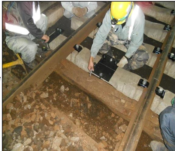
④ ロックプレートの凸部にパネルの凹部を合わせ、はめ込み敷設する。
