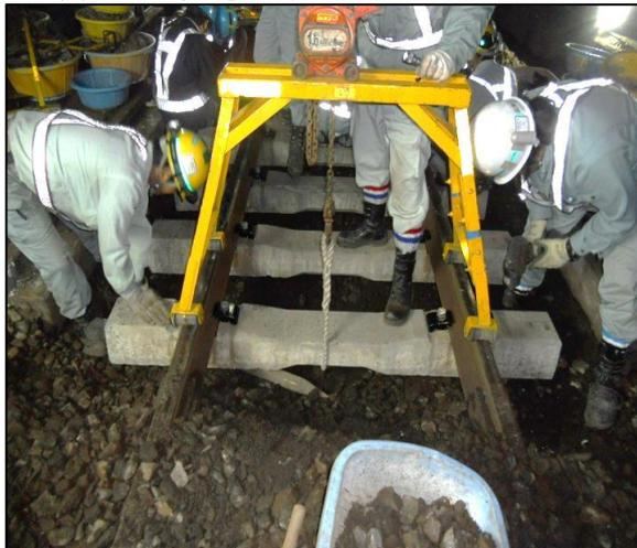
② ロックプレートの取付位置の確認と下部フラットバーとボルトによるプレートの固定をする。
