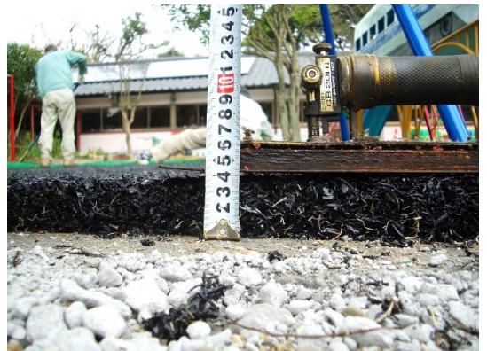
ベース層 リサイクルゴムチップ施工 40mm~100mm
